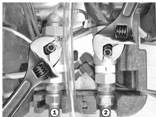
Fig. 8: Valvole a sfera semiaperte / aperte completamente
