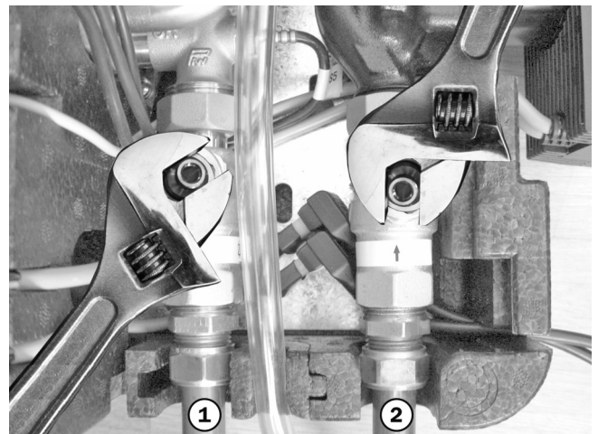
Fig. 8: Torneiras esféricas semi-aberta / completamente aberta
