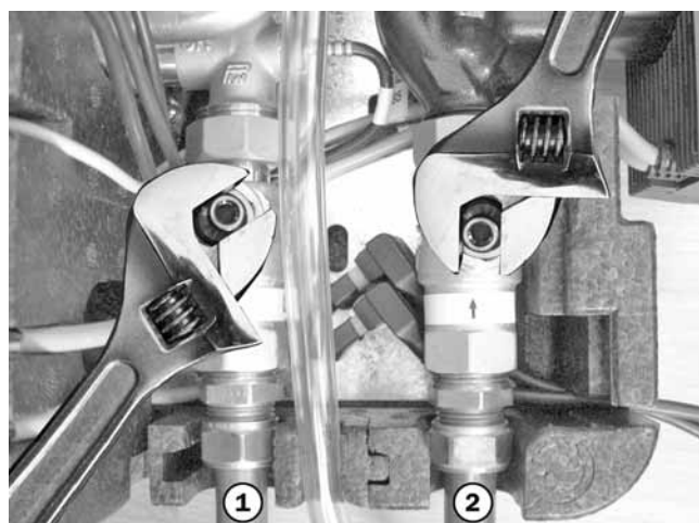
Fig. 8: Torneiras esféricas semi-aberta / completamente aberta
