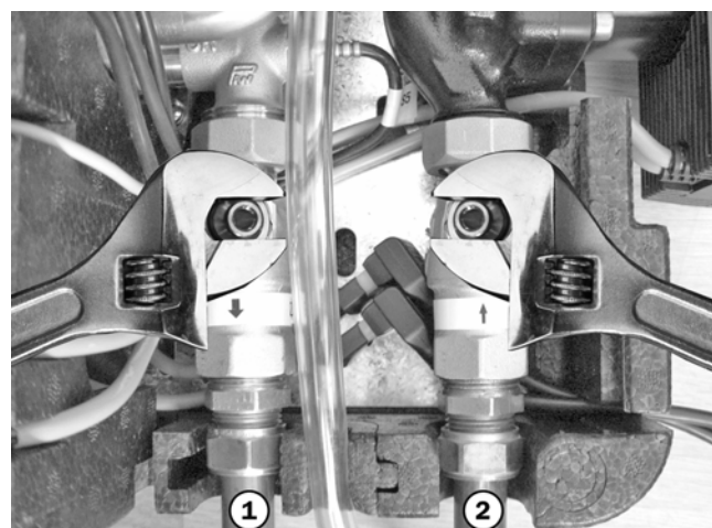
Fig. 7 : Robinets à boisseau sphérique fermés
