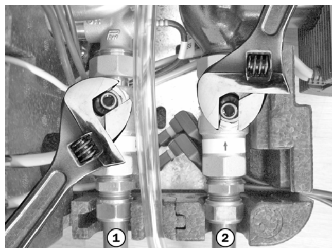
Fig. 8 : Robinets à boisseau sphérique ouverts à moitié / entièrement
