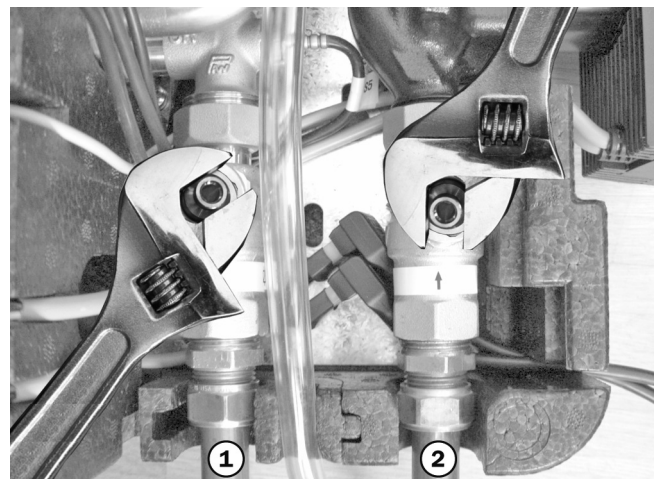
Afb. 8: kogelkranen half geopend / geheel geopend
