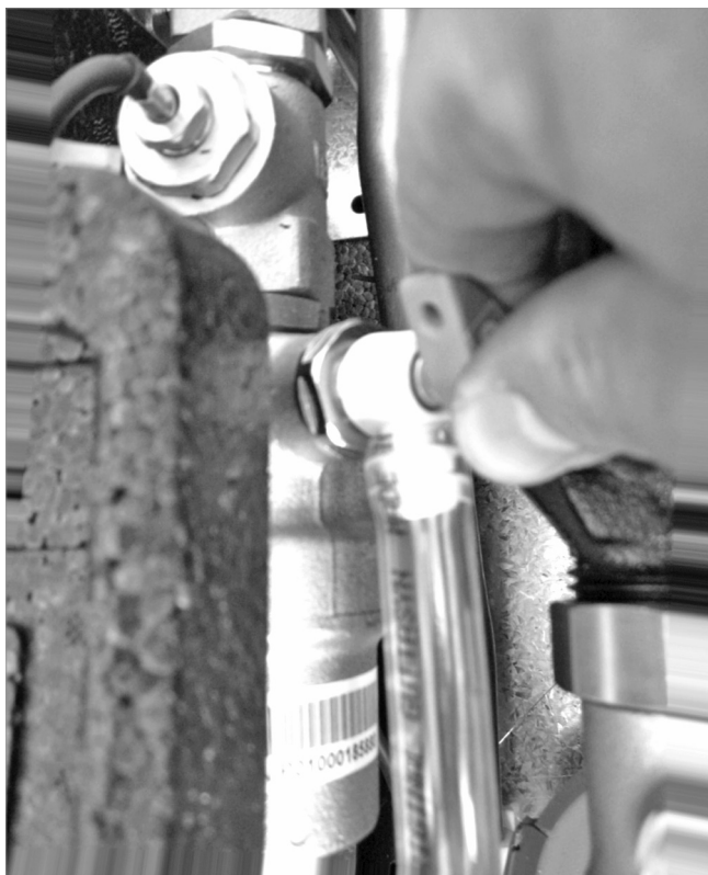
Afb. 11: Luchtvanger ontluichten
