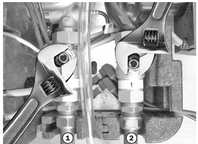
Afb. 8: kogelkranen half geopend / geheel geopend
