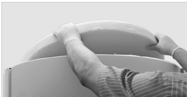
Abb. 10: Deckelronden auflegen
