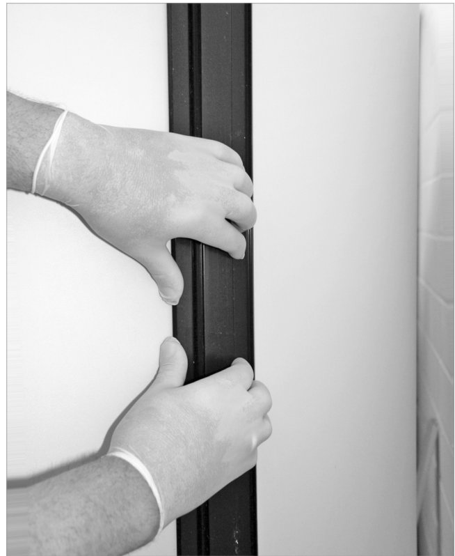
Abb. 8: Isolierteile schließen
