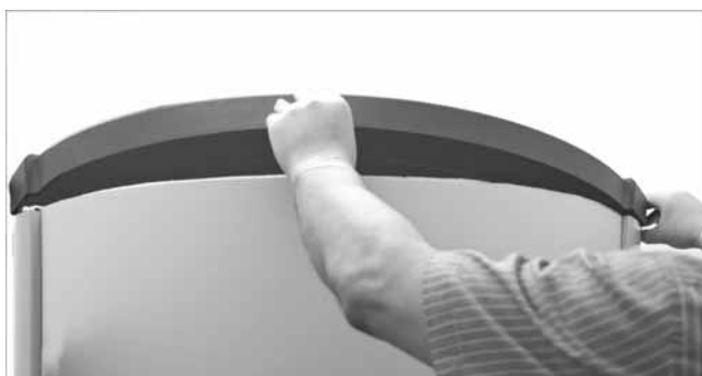
Abb. 11: Obere Abdeckung auflegen
