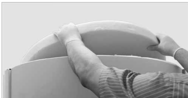
Abb. 10: Deckelronden auflegen
