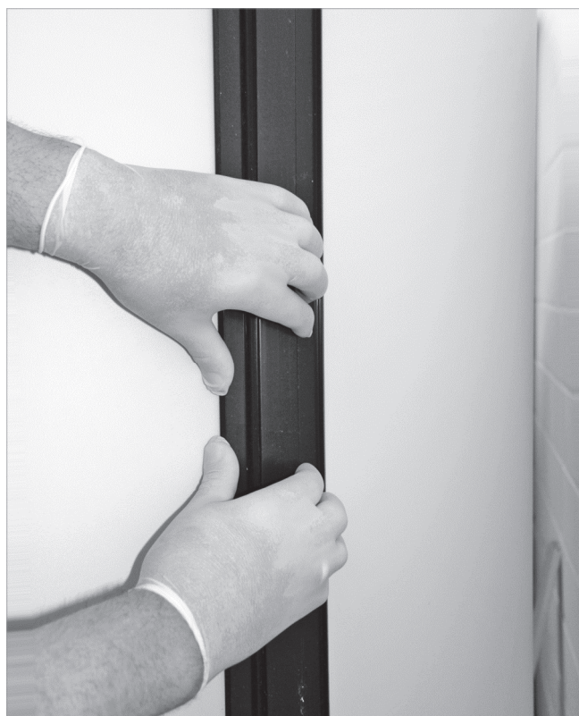
Fig. 8: Chiusura delle parti isolanti
