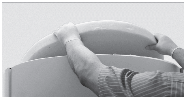
Fig. 10: Applicazione degli sviluppi circolari di copertura
