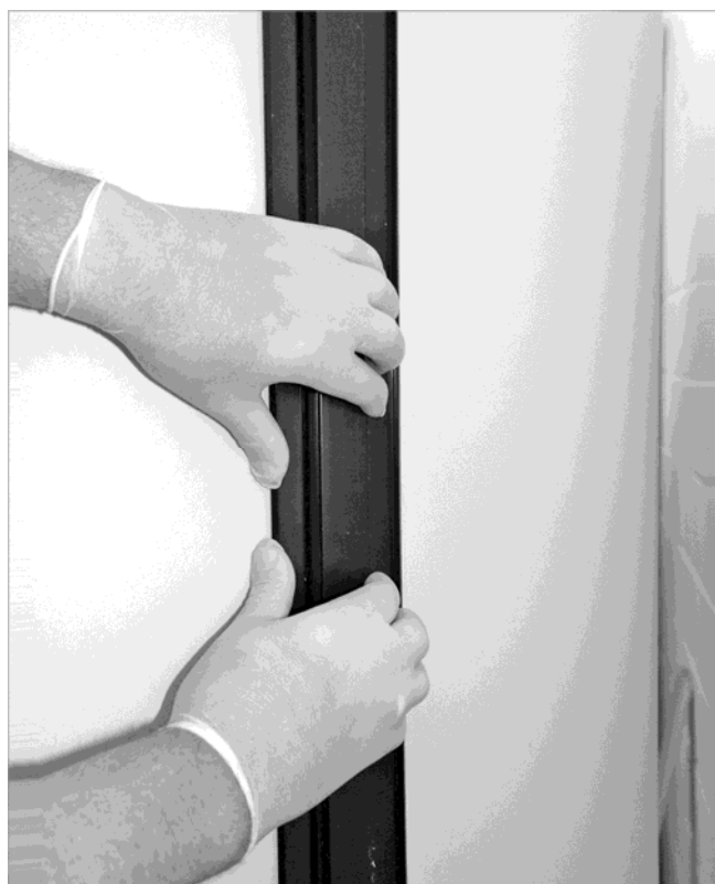
Fig. 8: Chiusura delle parti isolanti
