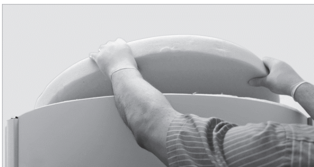
Fig. 10: Colocar los discos de la tapa
