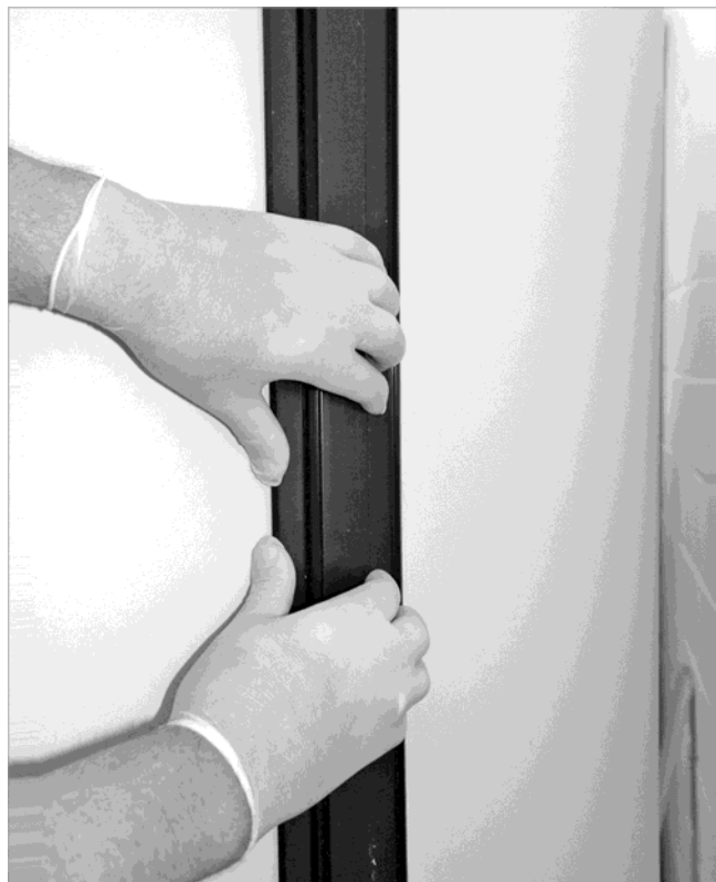
Fig. 8: Cerrar las partes aislantes
