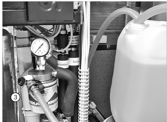
Abb. 89: Füllhahn am Filterdeckel (mit montiertem Solarkreisfilter)
