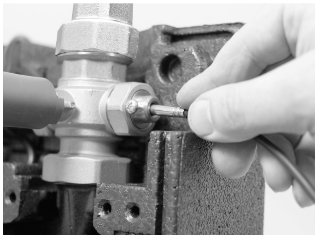
Abb. 59: Vorlauffühler montieren
