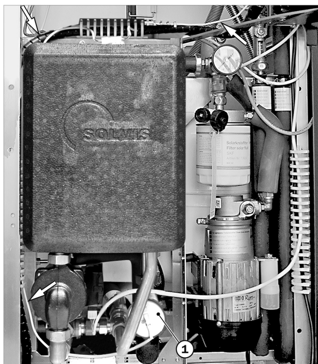
Abb. 48: Leitung VSG-W verlegen
