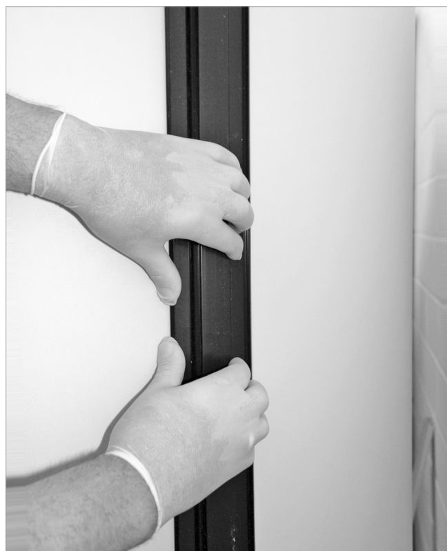
Abb. 74: Isolierung hinten schließen
