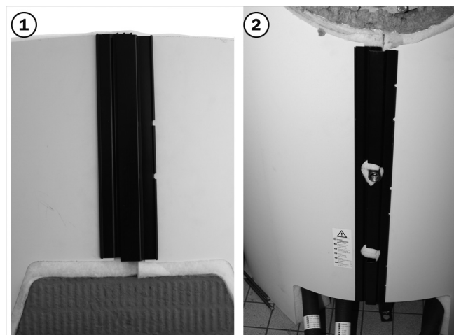
Abb. 73: Isolierung oben (1) und unten (2) schließen
