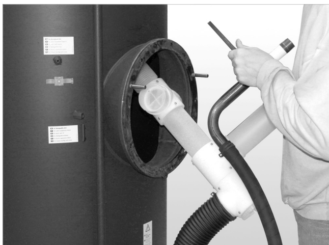
Abb. 79: Ladeflansch einschieben
