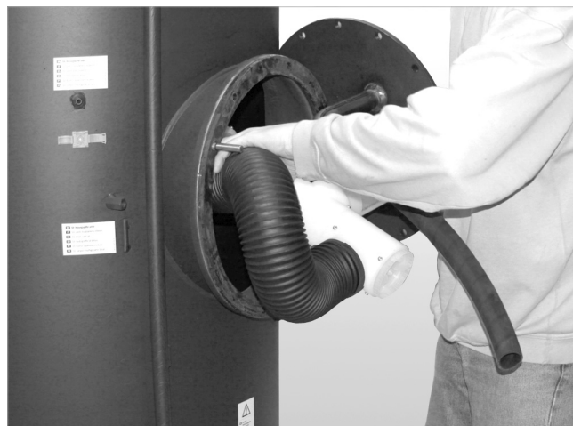
Abb. 80: Flexible Rohre einschieben
