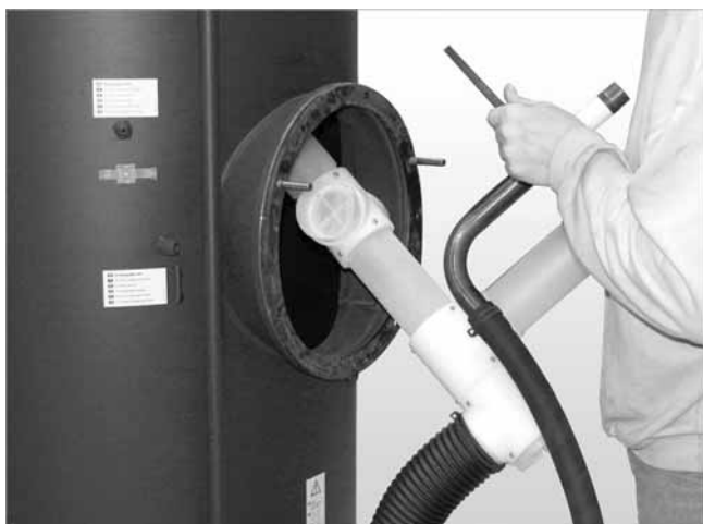
Abb. 79: Ladeflansch einschieben
