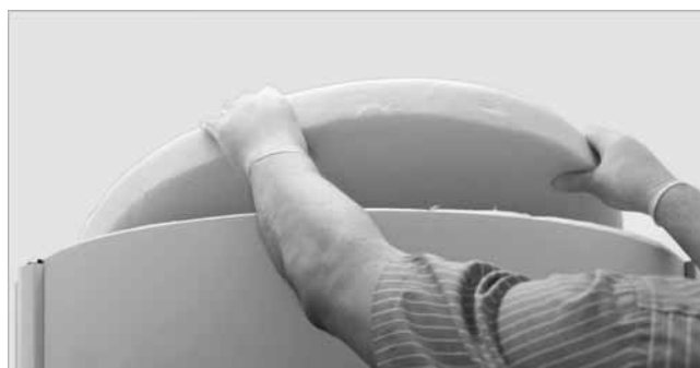
Abb. 76: Deckelrunde auflegen
