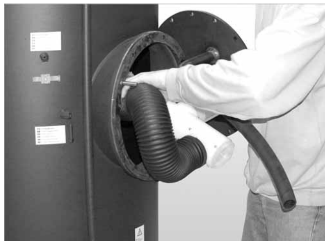
Abb. 80: Flexible Rohre einschieben
