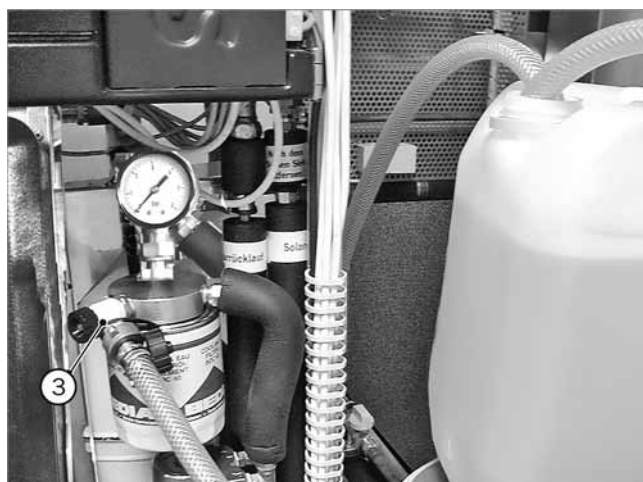
Abb. 89: Füllhahn am Filterdeckel (mit montiertem Solarkreisfilter)
