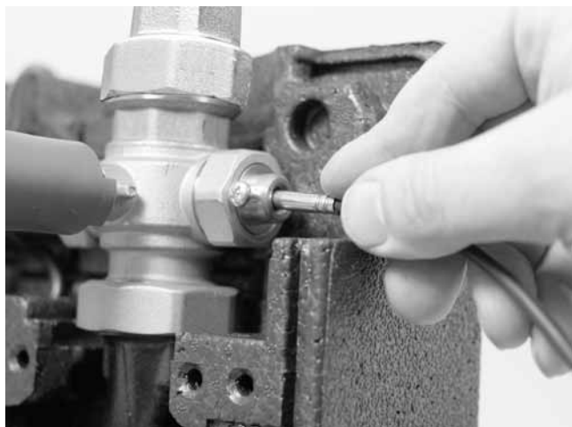
Abb. 59: Vorlauffühler montieren
