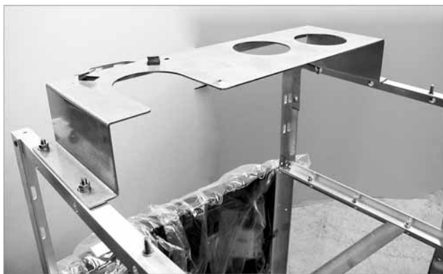
Abb. 37: Konsolenblech montieren
