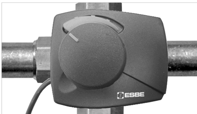
Afb. 40: mengklep met aandrijving en draaiknop
