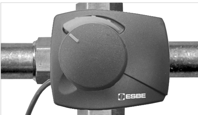
Abb. 5: Mischer mit Stellantrieb und Drehknopf
