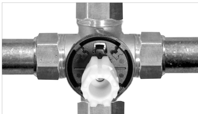
Fig. 17: Miscelatore con il giunto
