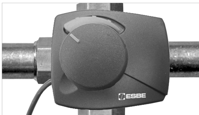
Fig. 19: Miscelatore con attuatore e manopola
