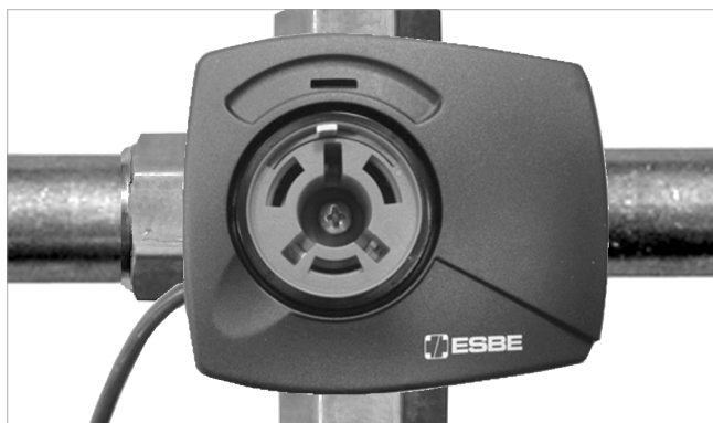
Fig. 18: Miscelatore con attuatore
