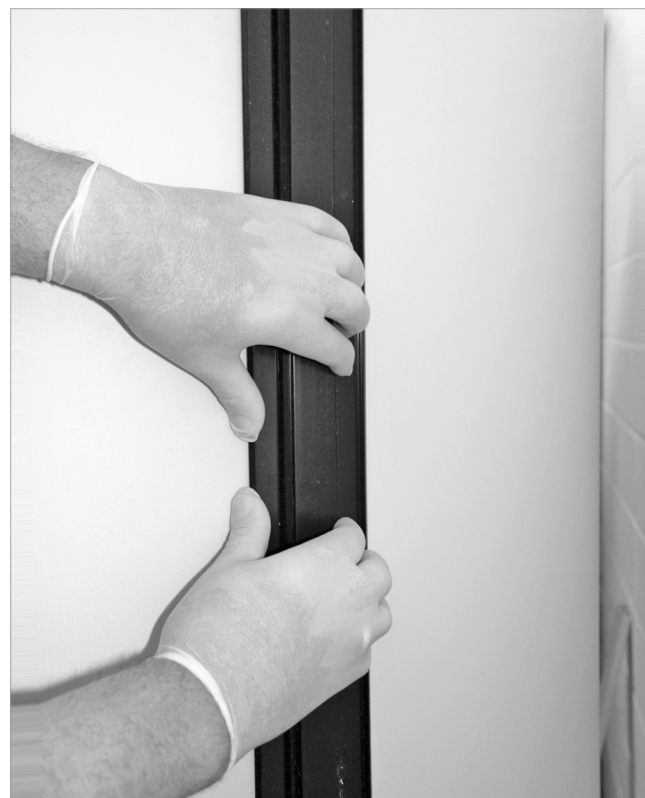
Fig. 7: Fechar a peça de isolamento
