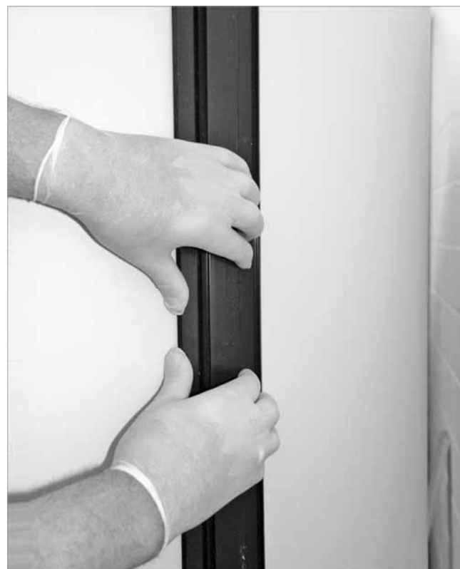
Fig. 7: Fechar a peça de isolamento
