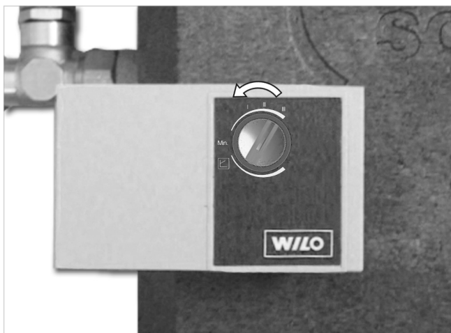
Abb. 6: Drehzahl einstellen
