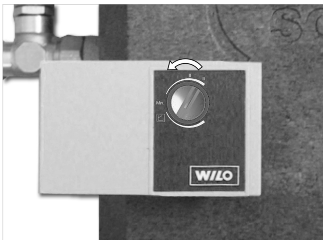
Fig. 14: Ajuste del número de revoluciones
