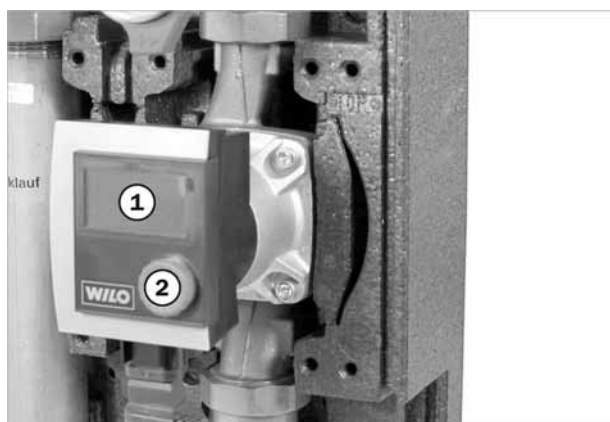
Abb. 19: Heizkreispumpe Wilo-Stratos PICO
