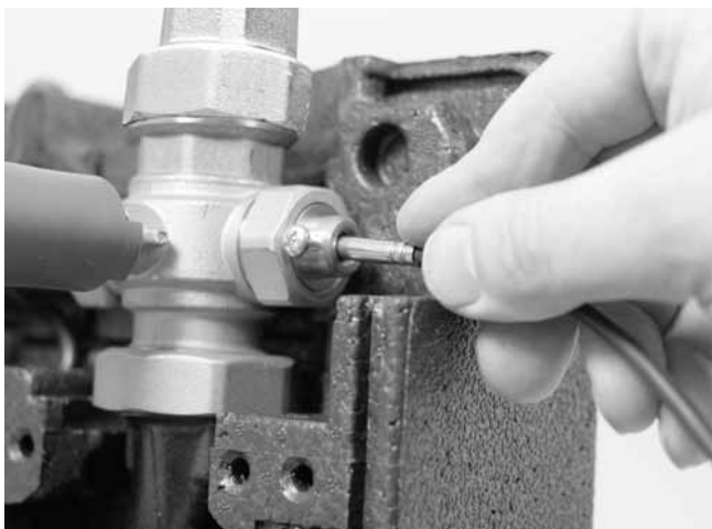
Abb. 15: Vorlauffühler montieren
