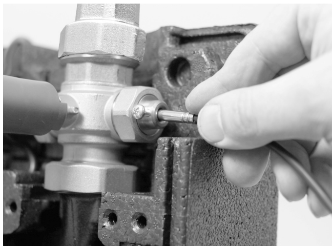
Abb. 15: Vorlauftemperaturfühler montieren
