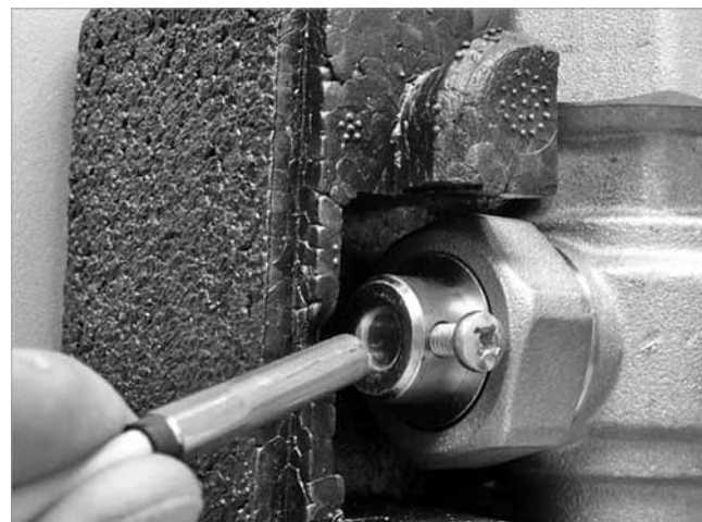
Abb. 3: Rücklauffühler montieren
