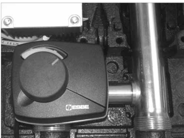
Abb. 7: Markierung zeigt nach rechts oben (geöffnet)
