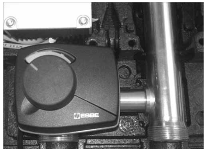
Abb. 9: Markierung zeigt nach links oben (geschlossen)
