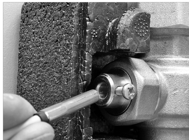
Abb. 3: Rücklauffühler montieren
