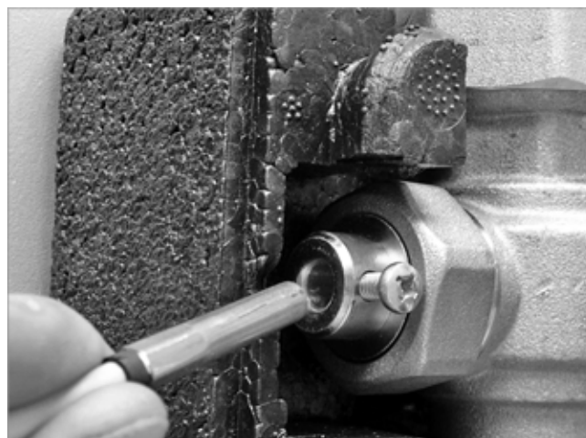
Fig. 3: Montaggio della sonda di temperatura del ritorno
