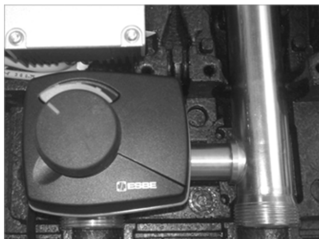
Fig. 9: Contrassegno punta in alto a sinistra (chiusa)
