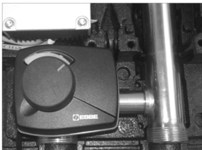
Fig. 7: Contrassegno punta in alto a destra (aperta)
