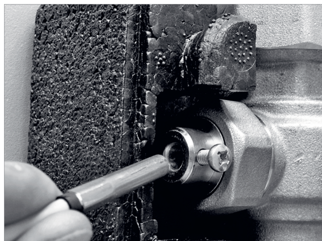
Fig. 3: Montaggio della sonda di temperatura del ritorno
