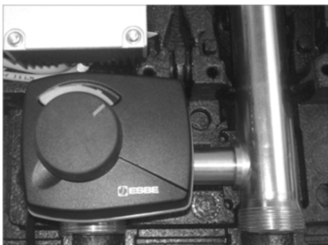
Fig. 7: Marca apuntando hacia la derecha superior (abierto)
