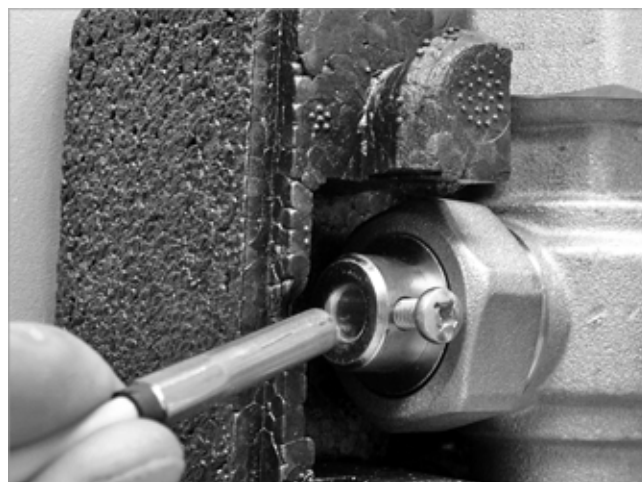
Fig. 3: Montaje del sensor de temperatura de retorno
