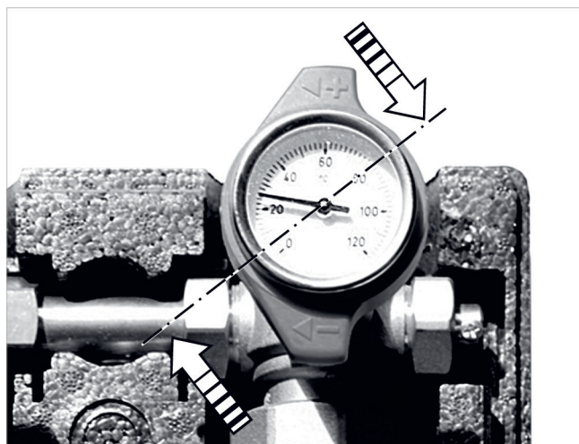
Fig. 4: Grifo esférico con termómetro integrado.
