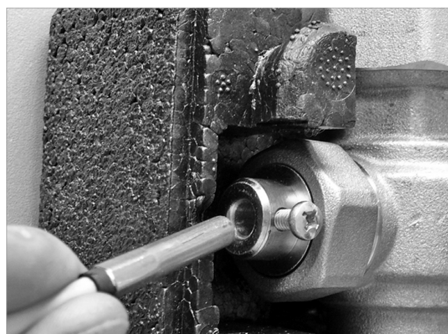
Fig. 9: Montar o sensor da temperatura de retorno
