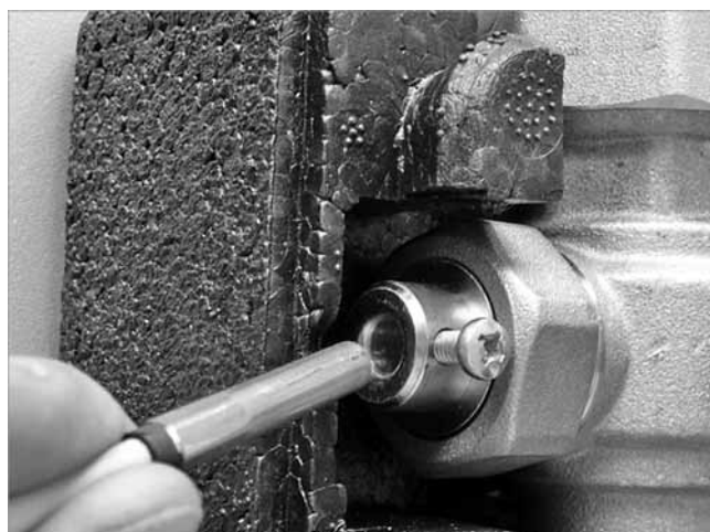
Fig. 9: Montar o sensor da temperatura de retorno
