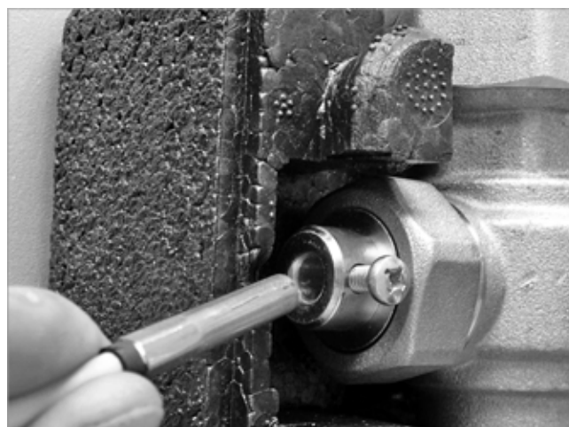
Afb. 3: Retourtemperatuurvoeler monteren
