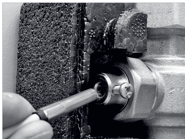
Afb. 3: Retourtemperatuurvoeler monteren
