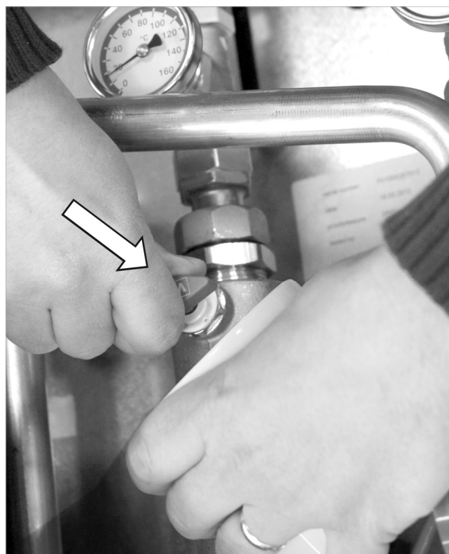
Fig. 11: Purga del separador de aire
