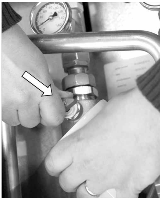
Fig. 11: Purga del separador de aire
