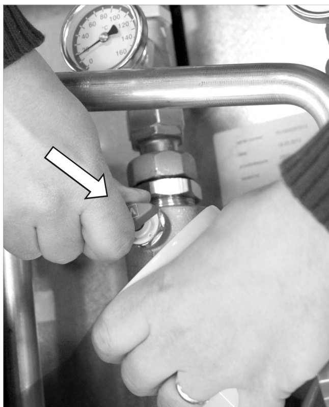
Fig. 11: Purgar o ar da recolha do ar
