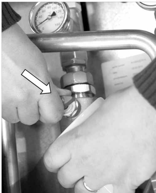
Fig. 11: Purgar o ar da recolha do ar
