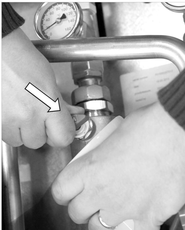
Afb. 11: Luchtvanger ontluichten
