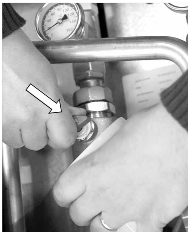
Afb. 11: Luchtvangervent ontluichten
