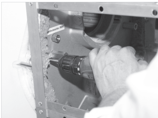
Abb. 15: Gewinde nachschneiden
