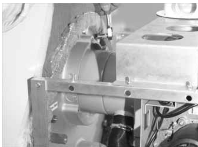
Abb. 10: Schrauben lösen
