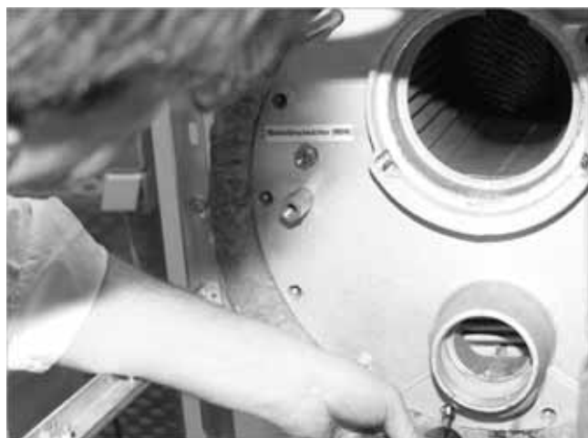
Abb. 17: Untere Gewinde nachschneiden
