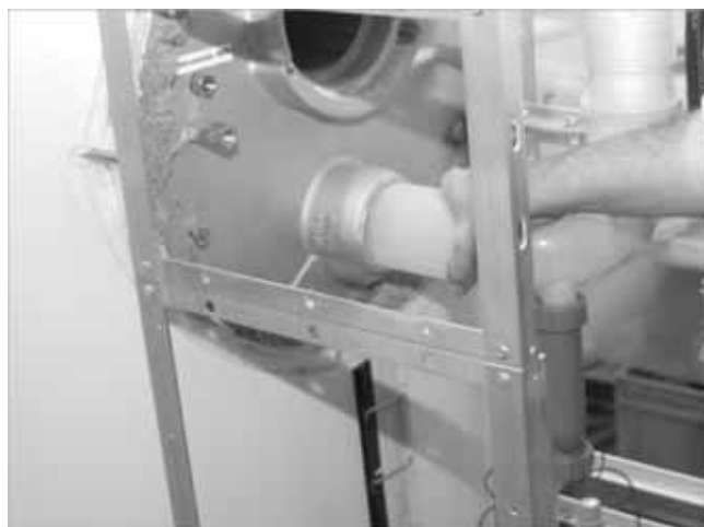
Abb. 12: Abgasrohr abziehen
