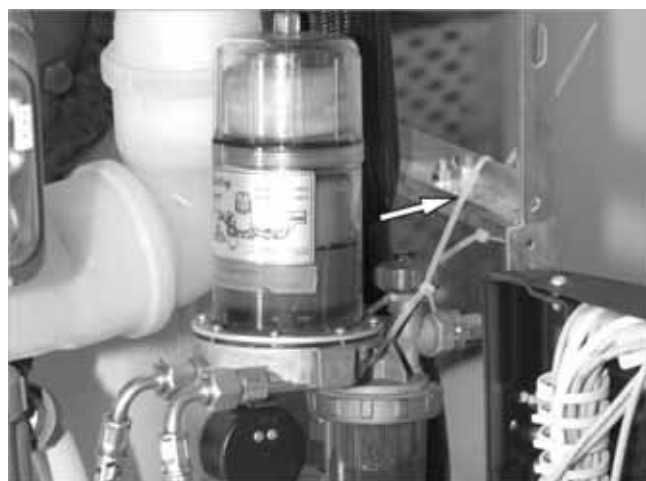
Abb. 7: Ölfilter fixieren
