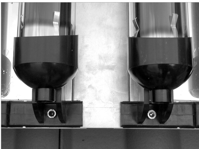
Abb. 31: Verbindungsblech unten bündig eingelegt, Röhren verschraubt
