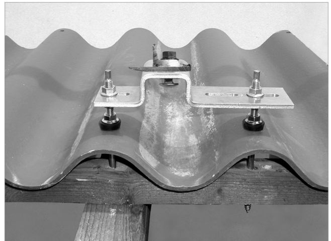
Afb. 69: Opbouw-dakbeugel gereed gemonteerd (methode B)
