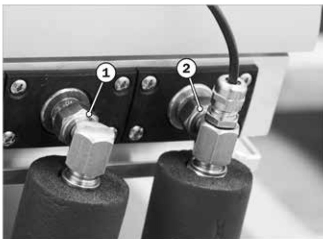
Abb. 71: Tauchsensord montiert, SolvisFera Integral
