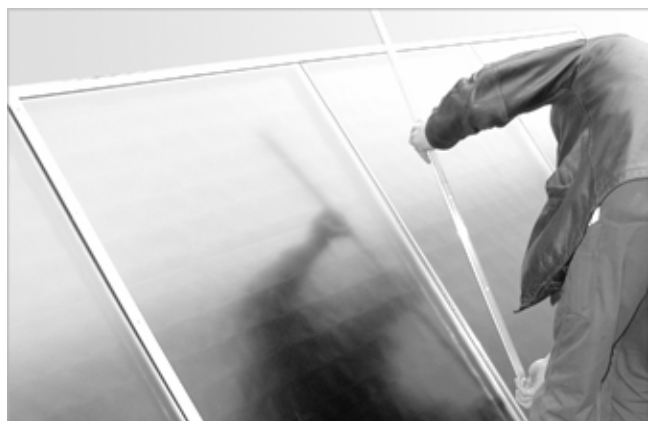
Abb. 37: Querträger-Abdeckleisten montieren
