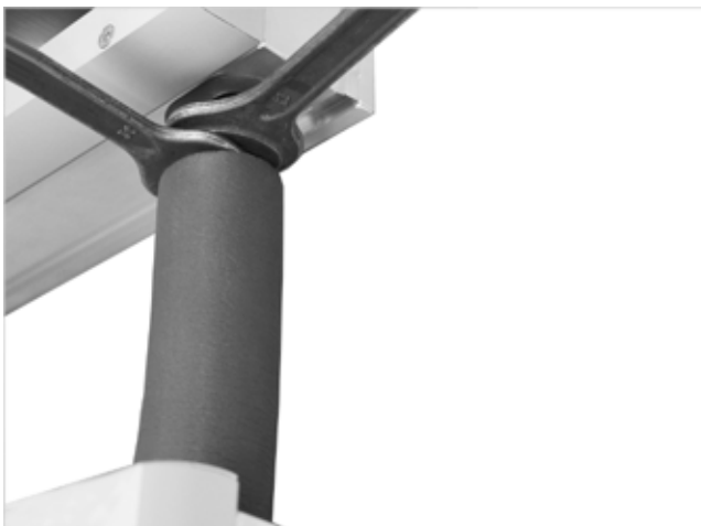
Abb. 69: VB-F-S-D-UE am oberen Anschluss verschrauben
