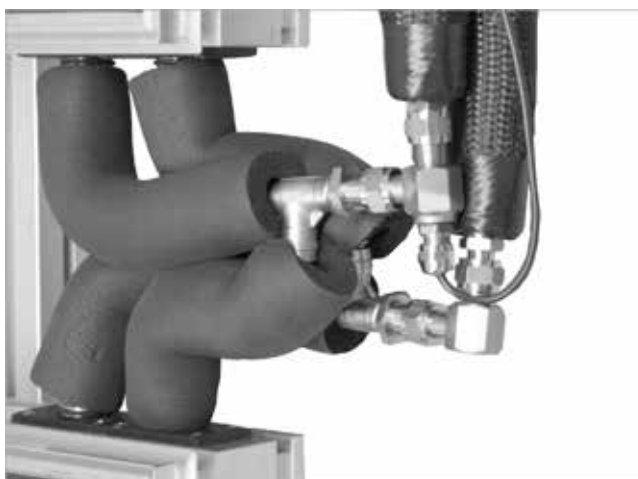
Abb. 53: Über Kreuz installierte Parallelverschraubung
