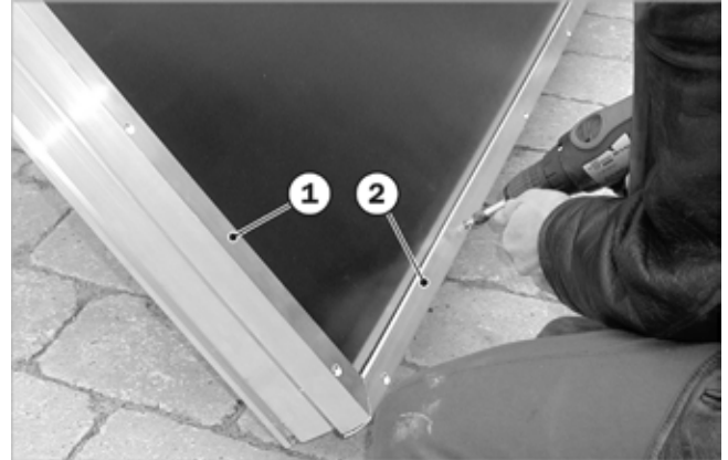
Abb. 34: Clip-Profile auflegen, ausrichten, verschrauben
