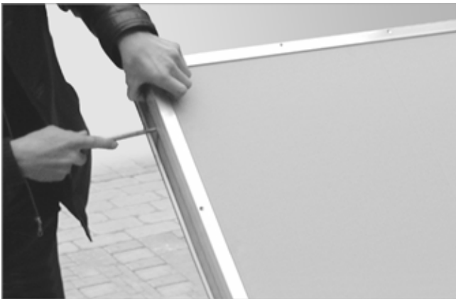
Abb. 32: Clip-Profile und Abdeckpappen entfernen
