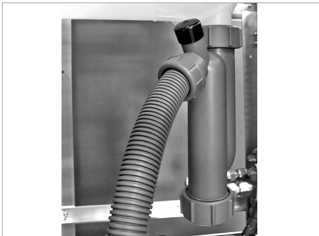
Abb. 12: Siphon mit Kondensatschlauch montieren
