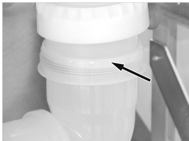
Abb. 10: Abgasbogen gerade ausgerichtet verschrauben
