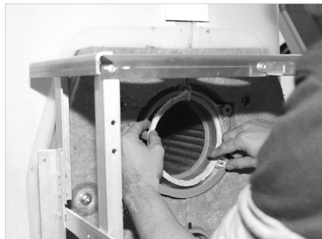
Abb. 3: Brennerdichtschnur einlegen
