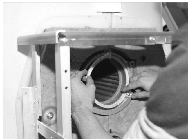
Abb. 3: Brennerdichtschnur einlegen
