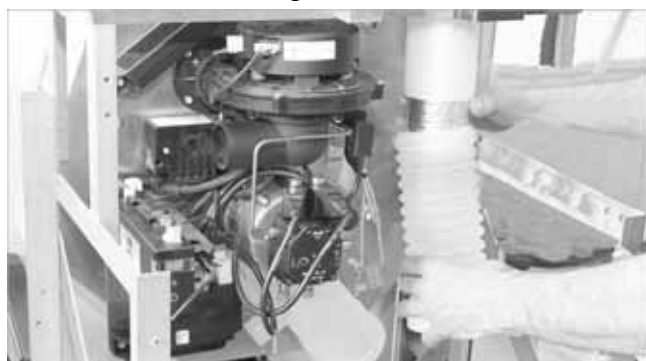
Abb. 12: Abgasanschlusstück aufstecken
