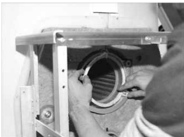
Abb. 1: Brennerdichtschnur einlegen
