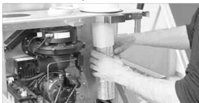
Abb. 11: Innenrohrschalldämpfer einsetzen
