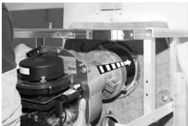
Abb. 7: Brenner einbauen
