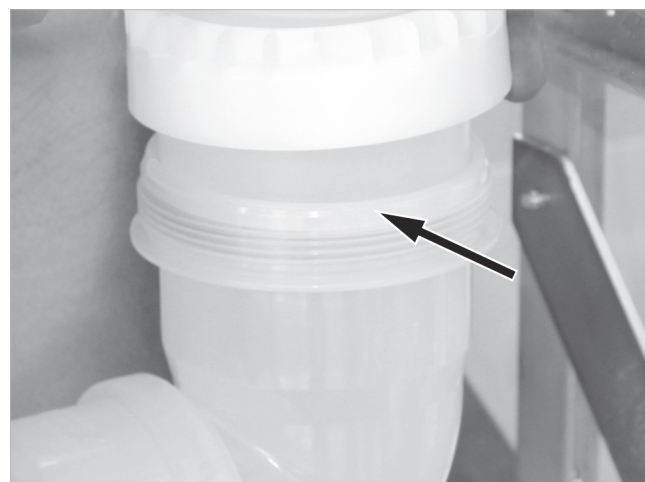
Abb. 15: Abgasbogen gerade ausgerichtet verschrauben
