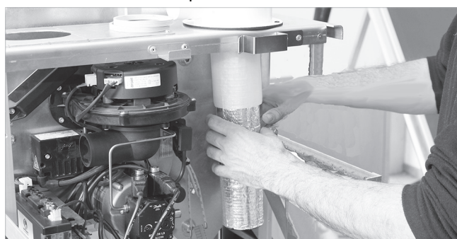
Abb. 11: Innenrohrschalldämpfer einsetzen
