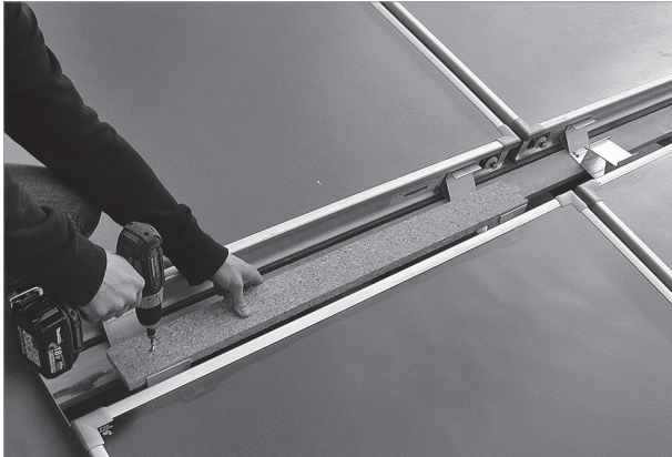
Abb. 67: Zwischenblechstützen auf Kollektordistanzstücke schrauben
