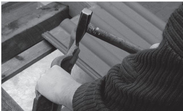
Abb. 86: Ggf. Haltenasen entfernen
