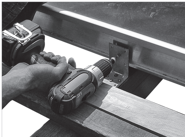
Abb. 50: An der oberen Stirnseite den Kollektor am Dachsparren fixieren
