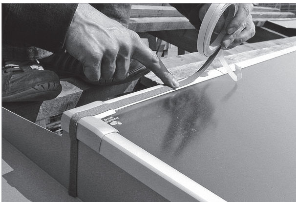
Abb. 68: Am oberen Rand Fugendichtband über ganze Breite aufkleben
