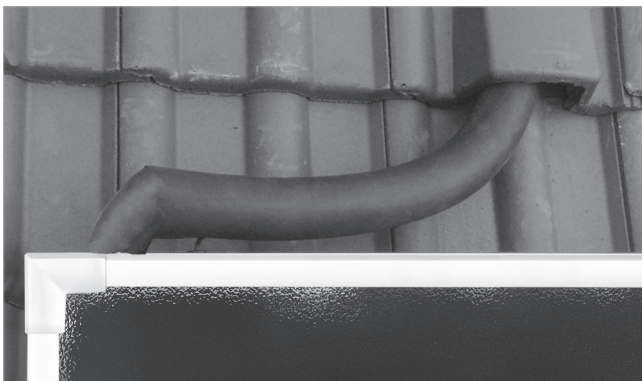
Abb. 92: Rücklauf anschließen
