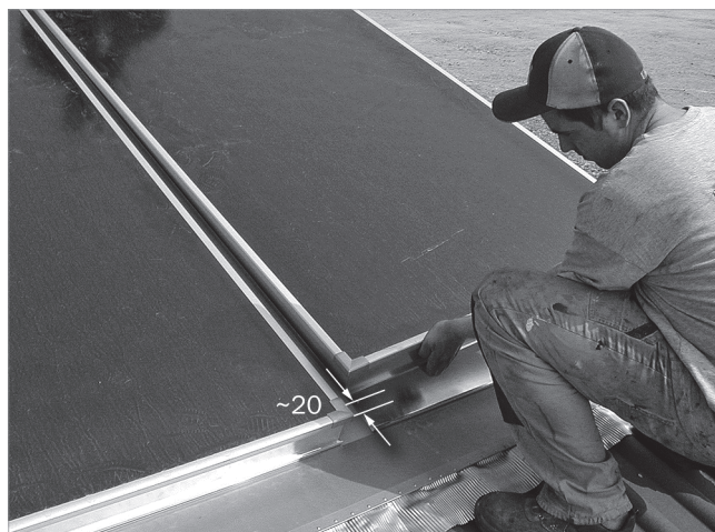
Abb. 53: Nächsten Kollektor aufsetzen und gegen das Halteblech nach unten schieben
