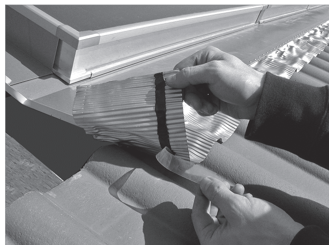
Abb. 48: Schutzstreifen abziehen und Bleischürzen andrücken
