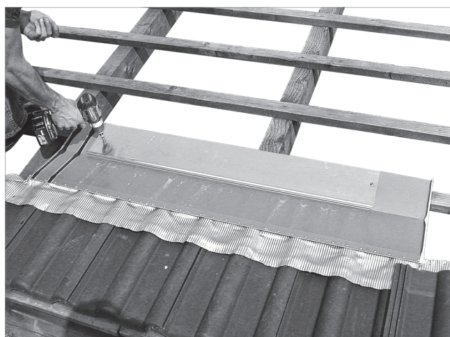
Abb. 46: Erstes Blech rechts auflegen und anschrauben
