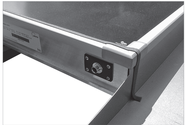
Abb. 78: Fugendichtband am oberen Rand über die ganze Breite aufkleben
