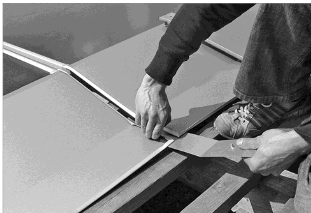
Abb. 80: Das untere Blech des Verbinders unter die Oberbleche schieben
