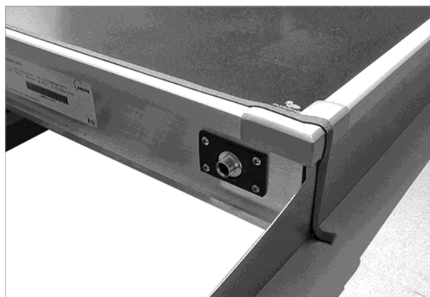
Abb. 78: Fugendichtband am oberen Rand über die ganze Breite aufkleben
