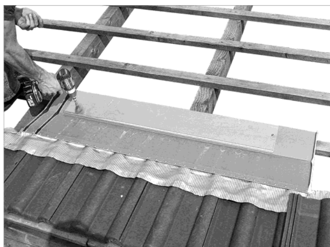
Abb. 46: Erstes Blech rechts auflegen und anschrauben
