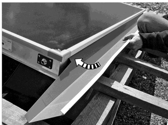
Abb. 63: Blech an die Nut unterm Clip-Profil setzen, dann an den Kollektor anlegen
