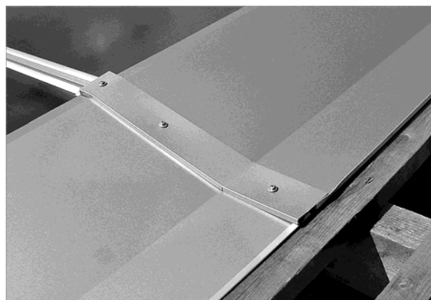
Abb. 82: Das obere Blech mit dem unteren Blech verschrauben
