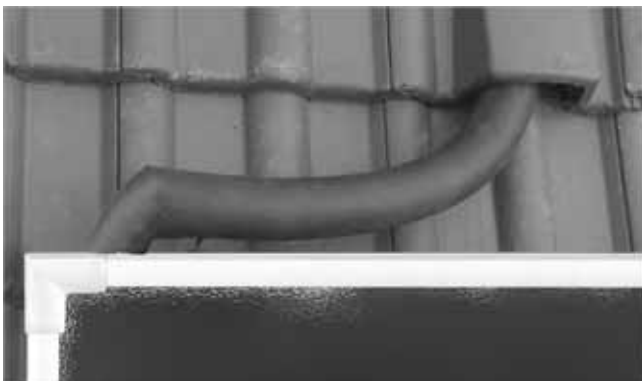
Abb. 92: Rücklauf anschließen
