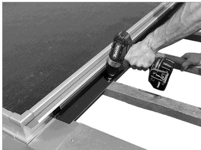
Abb. 52: Gegen den Anschlag nach unten schieben und mit den Dachlaten verschrauben
