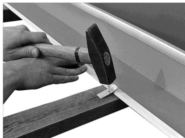
Abb. 66: Bleche mit Blechhaften an Dachlatten fixieren
