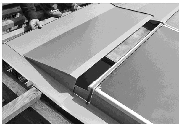
Abb. 79: Oberblech auf das Seitenblech aufsetzen und gegen den Kollektor schieben
