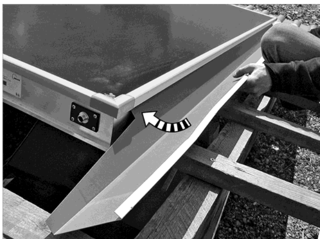
Abb. 55: Blech an die Nut unterm Clip-Profil setzen, dann an den Kollektor anlegen
