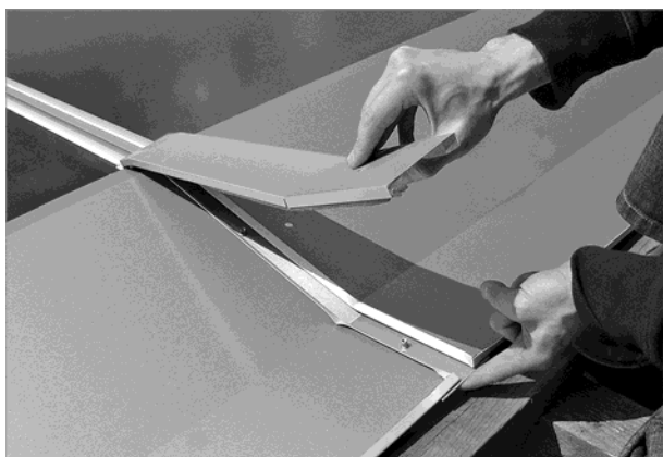
Abb. 81: Das obere Blech des Verbinders mit dem unteren in Deckung bringen
