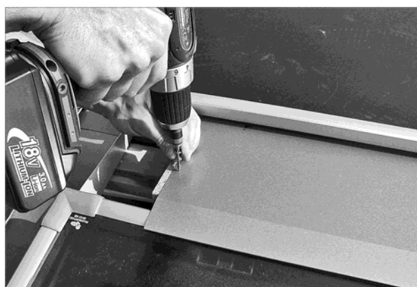
Abb. 71: Zwischenblech etwa 10 mm von linker Außenkante anschrauben
