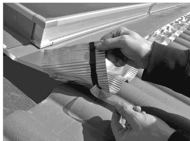
Abb. 48: Schutzstreifen abziehen und Bleischürzen andrücken
