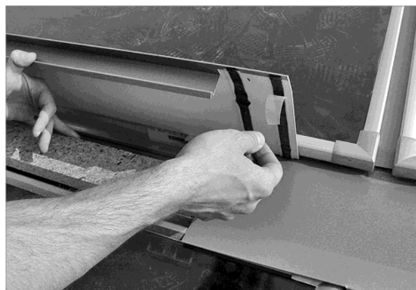
Abb. 74: Weitere Bleche montieren: Vor dem Auflegen Schutzstreifen abziehen
