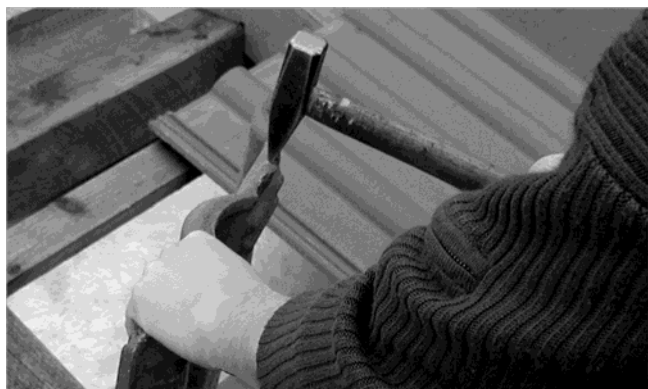
Abb. 86: Ggf. Haltenasen entfernen
