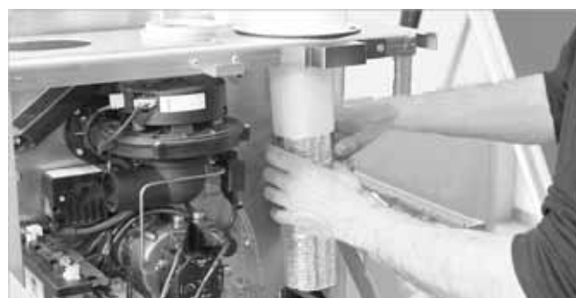
Fig.11: Montaggio fonoassorbente per la parte interna del tubo
