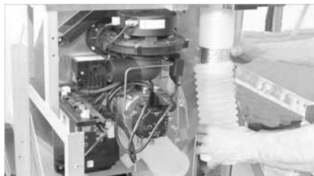
Fig.12: Montaggio raccordo per lo scarico dei fumi
