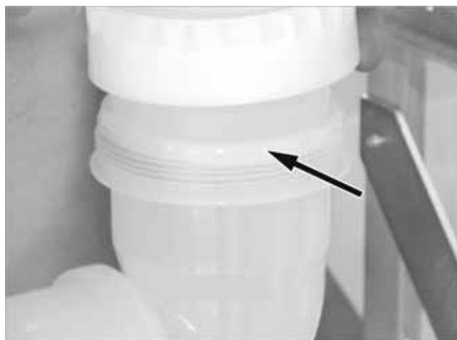
Fig. 15: avvvitamento allineato della curva della tubazione fumi
