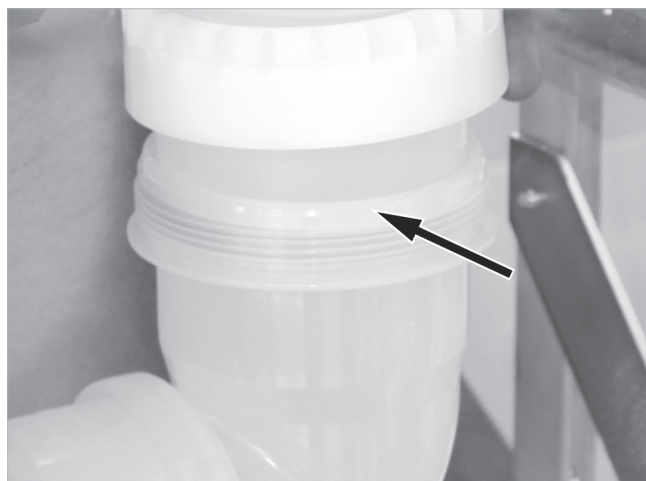
Fig. 15: Enroscado del codo de salida de humos alineado recto
