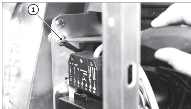
Fig. 31: Tornillos de cierre rápido en la unidad del quemador
