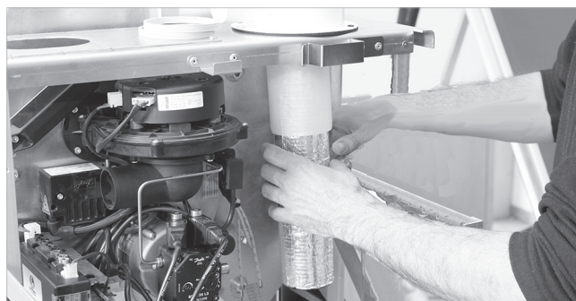
Fig. 11: Colocación del silenciador de tubo interior
