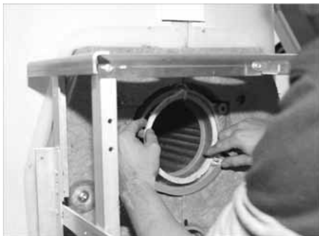
Fig. 1: Colocación del cordón de cierre hermético
