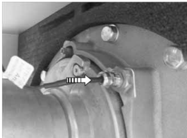
Fig. 20: Introducción del termostato mecánico de seguridad
