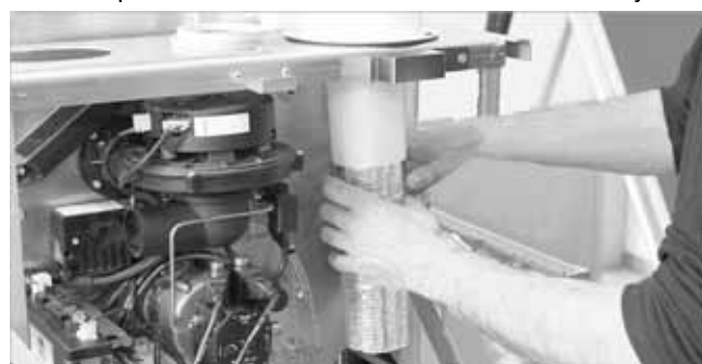
Fig. 11: Colocación del silenciador de tubo interior
